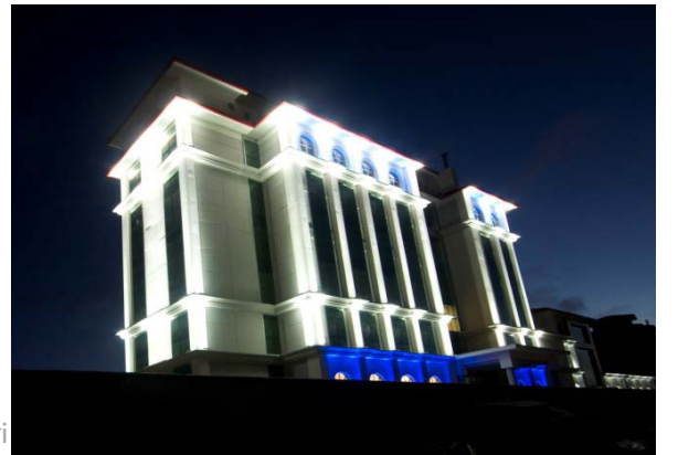
Eskişehir Osman Gazi University - Eskişehir | Turkey Eskişehir Osman Gazi Üniversitesi - Eskişehir | Türkiye
